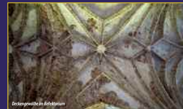
Deckengewölbe im Refektorium
